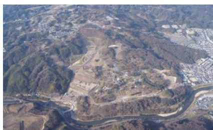
亀の瀬地すべり地区
