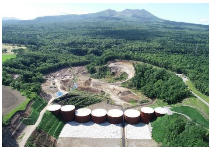
樽前山 覚生川砂防堰堤
