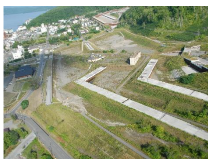
有珠山 西山川砂防堰堤
